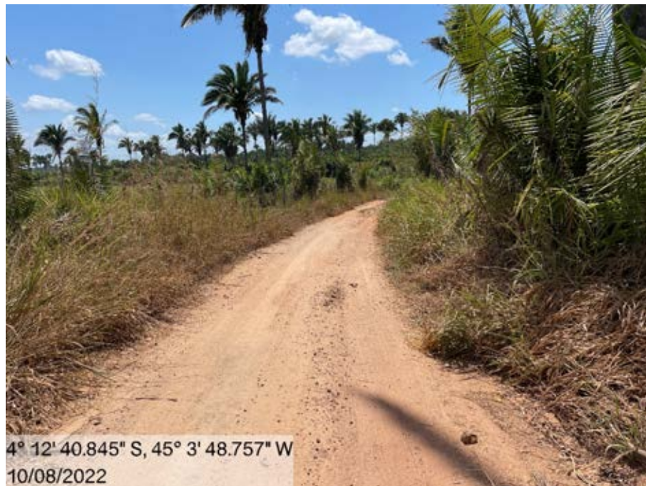
Figura 54: Fim do trecho 03, Povoado Sebastião do Salgado ao Povoado Centro dos Caianos.
