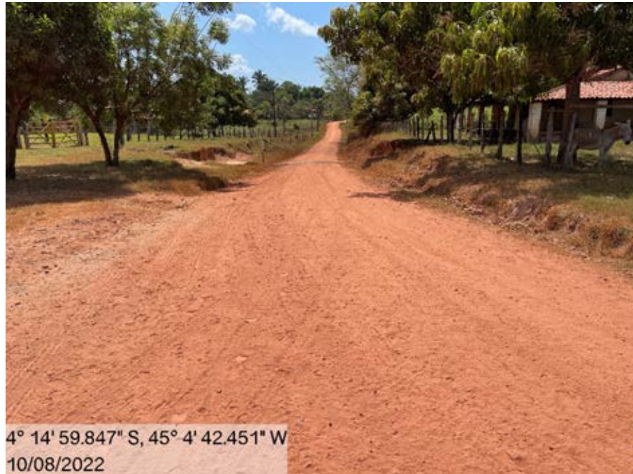
Figura 33: Início do trecho 03, Povoado Sebastião do Salgado ao Povoado Centro dos Caianos.
