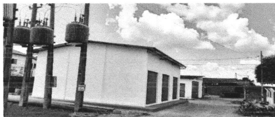
Imagem 02: Fachada lateral da unidade depósito
