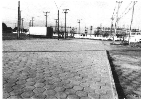
Imagens 11 e 12: Subestação e Pavimentação – Caxias
