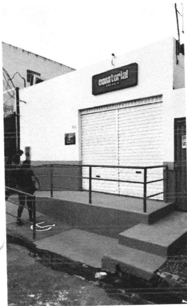
Imagem 04: Rampa de Acessibilidade na entrada da Agência de Atendimento
