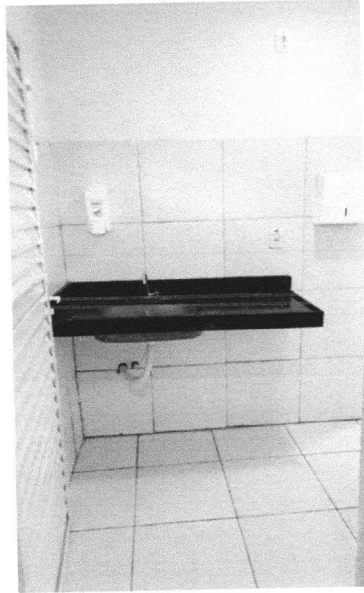
Imagem 02: Bancada em Granito em WC Agência
