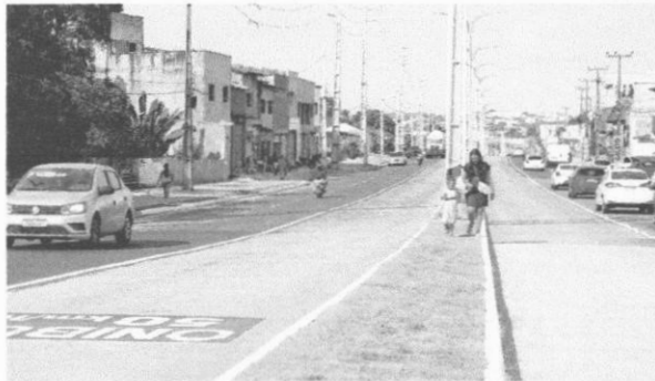
A obra na Estrada do Araçagi, que foi iniciada no ano de 2019, deveria ter sido entregue no ano passado
