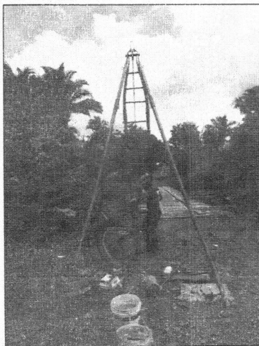
EXECUÇÃO DA SONDAGEM A PERCUSSÃO – SPT – 02
