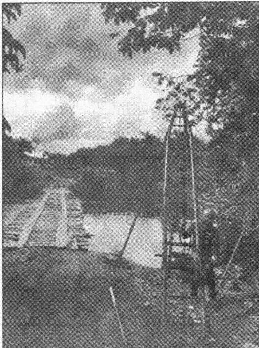
EXECUÇÃO DA SONDAGEM A PERCUSSÃO – SPT – 01
