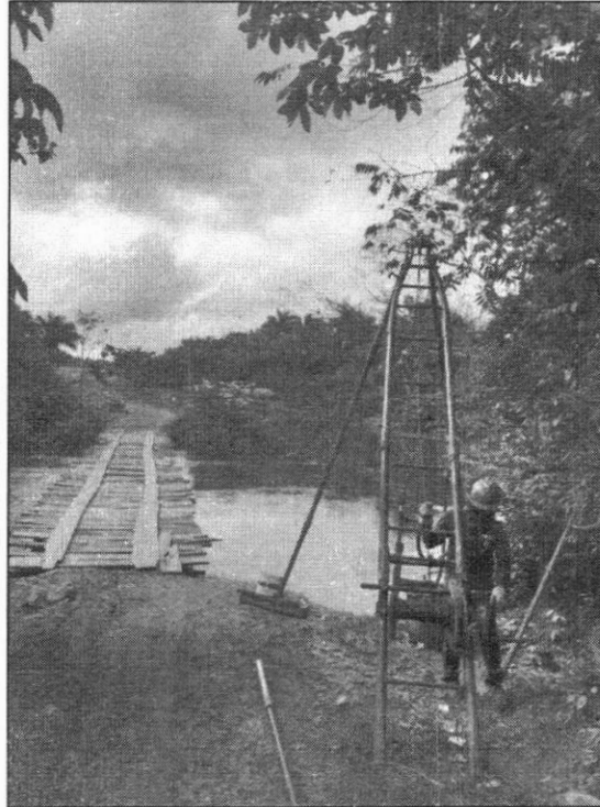
EXECUÇÃO DA SONDAGEM A PERCUSSÃO – SPT – 01
