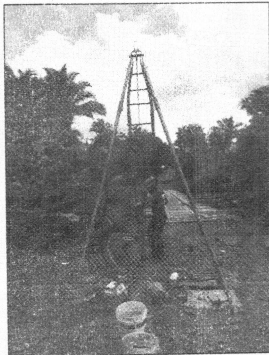
EXECUÇÃO DA SONDAGEM A PERCUSSÃO – SPT – 02
