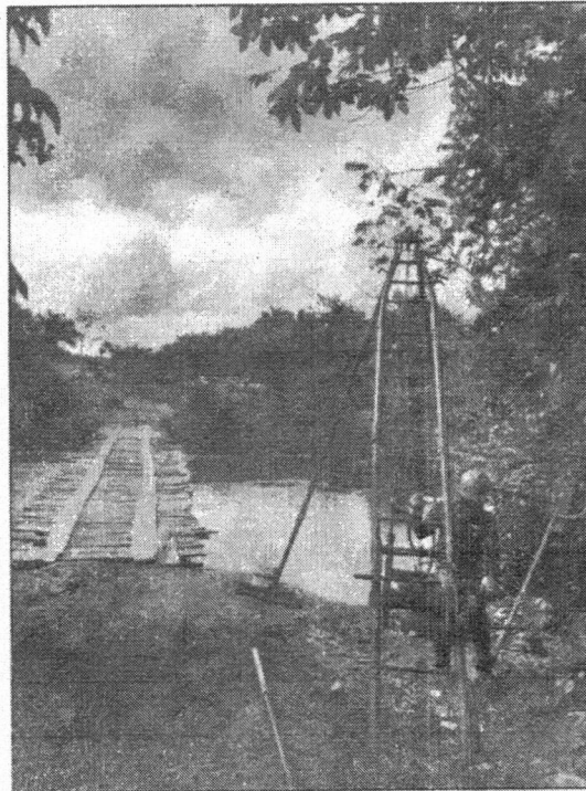
EXECUÇÃO DA SONDAGEM A PERCUSSÃO – SPT – 01
