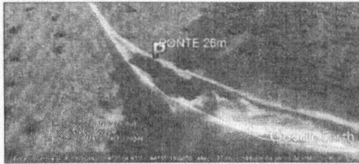
PONTE DE 26 METROS NO POVOADO MORADA NOVA COORDENADA DE LOCALIZAÇÃO
